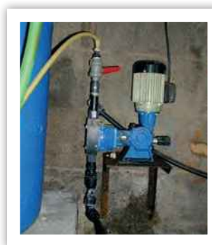
Equipos de inyección para aplicación de fitosanitarios en el riego localizado (Venturi a la izquierda, bomba de membrana a la derecha)
