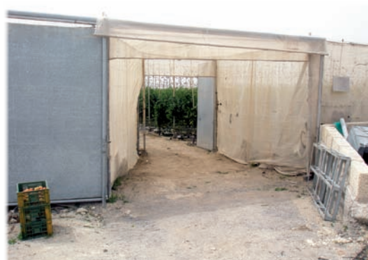
Figura 6: Dobles puertas en invernaderos
