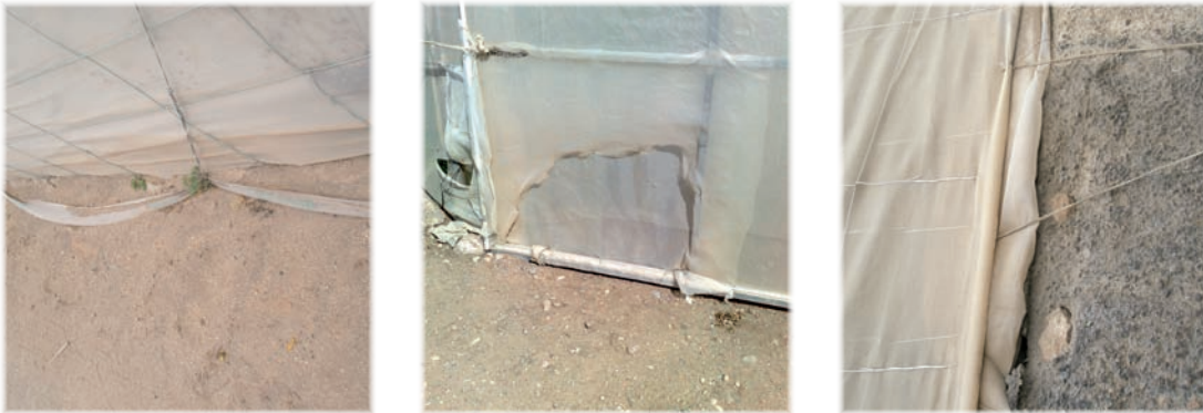
Figura 28: Invernaderos cerrados al paso de insectos: Cierre de la parte inferior (izquierda y derecha) y tapado de agujeros (centro).
