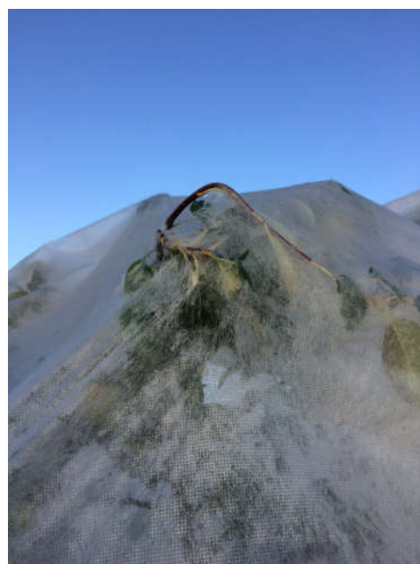
Foto 17.- Rotura de manta térmica por rama.
